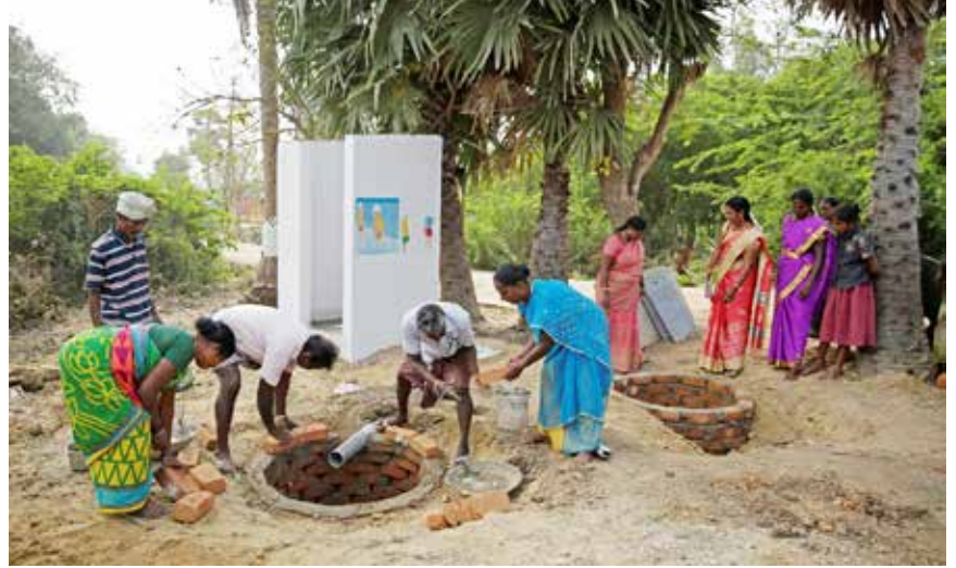
तमिलनाडु के कांचीपुरम में राजमिस्त्री दोहरे गड्ढे वाले शौचालय के निर्माण में जुटे हैं। स्वच्छता सुविधाओं की बढ़ती मांग को ध्यान में रखते हुए पर्याप्त मानव संसाधन जुटाने के लिए राजमिस्त्रियों का प्रशिक्षण जरूरी है
